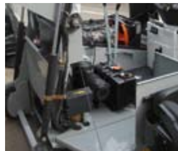
Aufgeräumte, gut zugängliche Technik. (Sweep 90 / 100 / 120)
